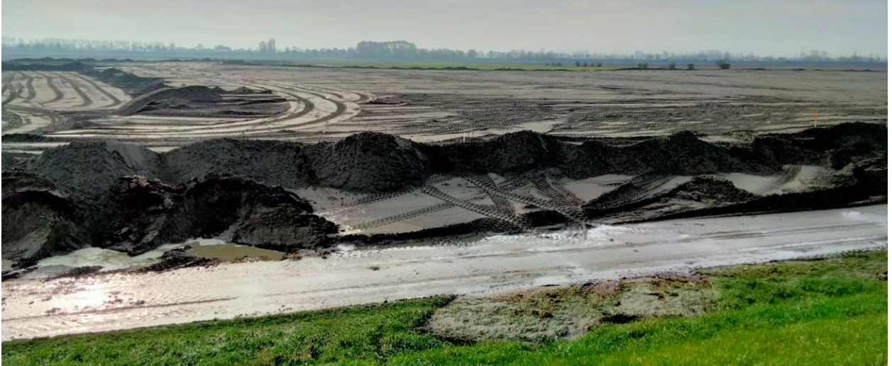
Foto 1 (voor fotorichting, zie tekening bijlage 2), zand aangevoerd op 24 november 2022 en aangebracht als derde laag van 2 tot 3 m op maaiveld.
