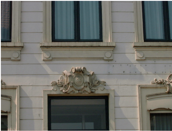
Bestaande authentieke geveldetailleringen behouden.
