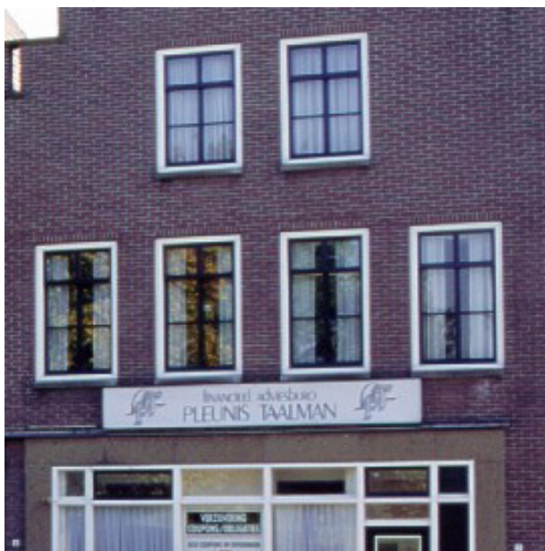
Reclameborden onder raamdorpels van verdieping.
