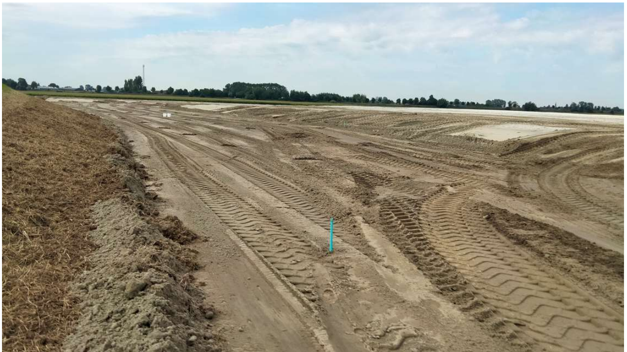
Foto 4 overzicht van het op 10 augustus 2023 aangebrachte zand, op de achtergrond de ophoging van de eerdere fase
