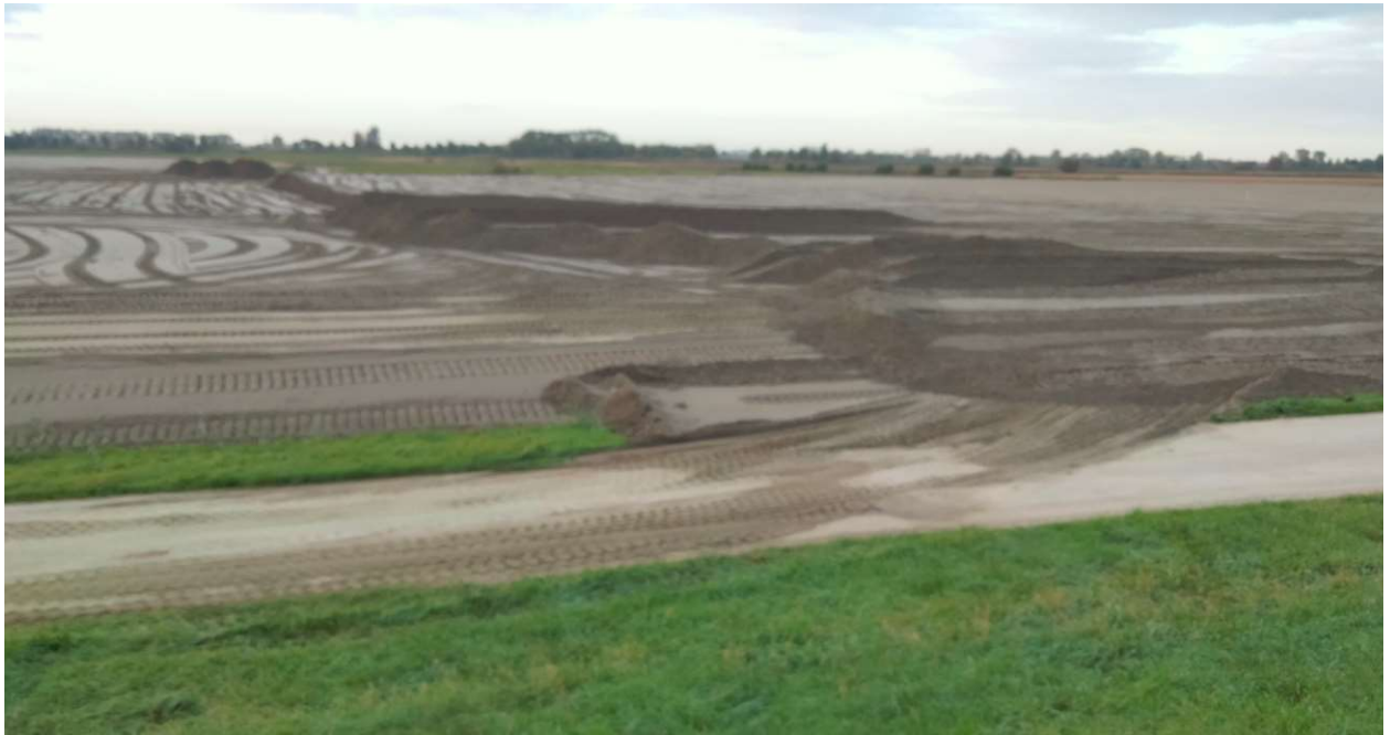
Foto 3 (voor fotorichting, zie tekening bijlage 2) met rechts de tweede laag opgebracht zand (1-2 m op maaiveld). Aan de linkerkant van de foto nog de eerste laag zand (0-1 m op maaiveld) zichtbaar.
