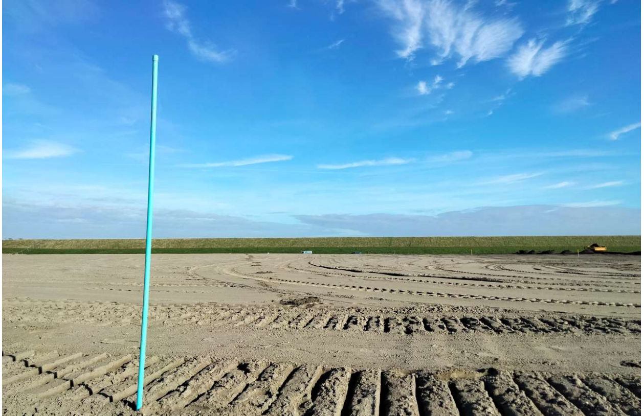
Foto 1 (voor fotorichting, zie tekening bijlage 2), zand aangevoerd op 3 oktober 2022 en aangebracht als tweede laag van 1 tot 2 m op maaiveld. Op de achtergrond de Zeedijk.
