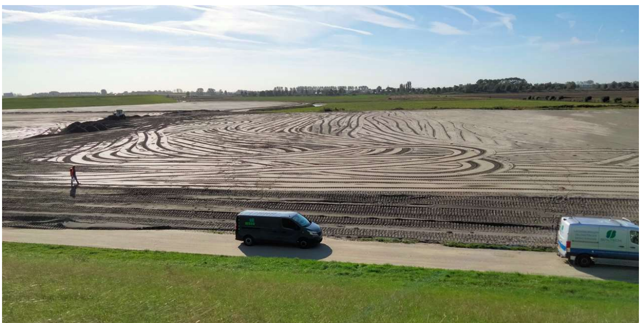
Foto 2 (voor fotorichting, zie tekening bijlage 2), zand aangevoerd op 3 oktober 2022 en aangebracht als tweede laag van 1 tot 2 m op maaiveld. Foto vanaf de Zeedijk genomen.
