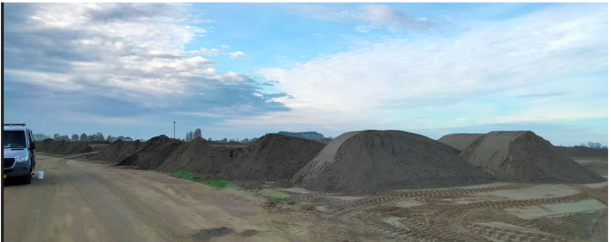
Foto 2 (voor fotorichting, zie tekening bijlage 2), zand aangevoerd op 27 oktober 2022 en aangebracht als tweede laag van 1 tot 2 m op maaiveld.
