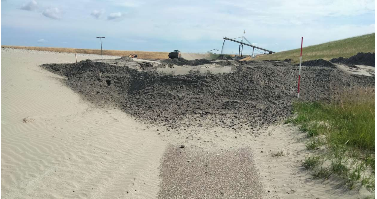
Foto 1 van het zand (donker grijs van kleur) dat is aangevoerd op 26 juni 2023 en aangebracht als eerste laag van 0 tot 1 m op de oude asfaltweg. Het witte zand is tijdens de periode augustus 2022-november 2022 aangebracht.
