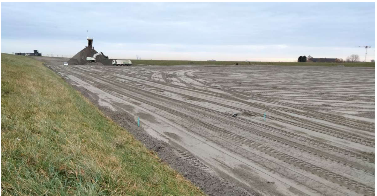
Foto 4: aangebracht zand van partij 12
