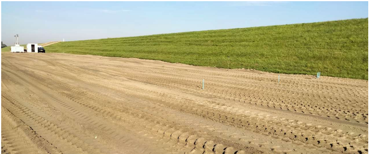
Foto 2: uitgezette partij 9 derde laag zand van 1 m dik tegen de Zeedijk
