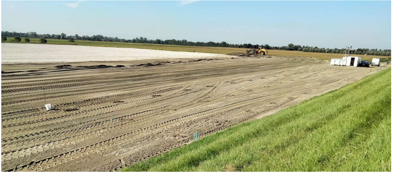
Foto 3: aangebracht zand van partij 9, foto vanaf de zeedijk
